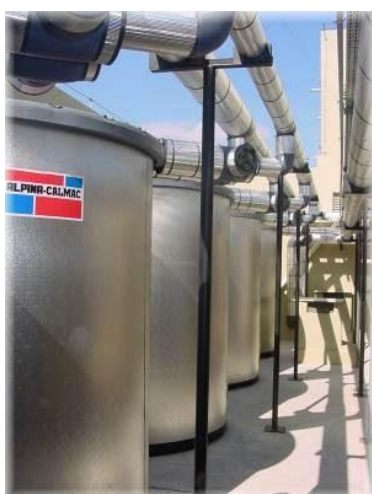
Figura 77. Sistema de Termoacumulação. Fonte: Sistemas de ar condicionado (2018). Disponível em: < http://www.sistemasdearcondicionado.com.br/2008/11/sistemas-de-termoacumulao.html > (Acesso em 26/06/2018).
