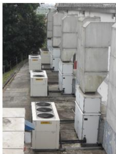
Figura 65. Rooftop e Self contained. Fontes: Mitsidi Projetos e SERAE (2018). Disponível em < https://serae.com.br/self-contained.php > (Acesso em 26/06/2018).
