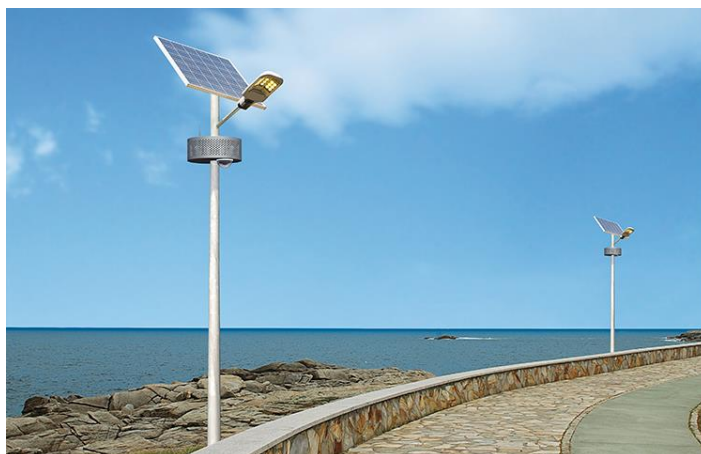
Figura 30. Poste de iluminação com módulos fotovoltaicos. Fonte: SUNVIENERGY. Disponível em < https://www.sunvienergy.com/fr/produits/poteau-intelligent/ > (Acesso em 20/07/2018).
